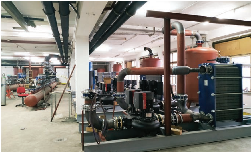
Tijek radova na rekonstrukciji glavne rashladne stanice
