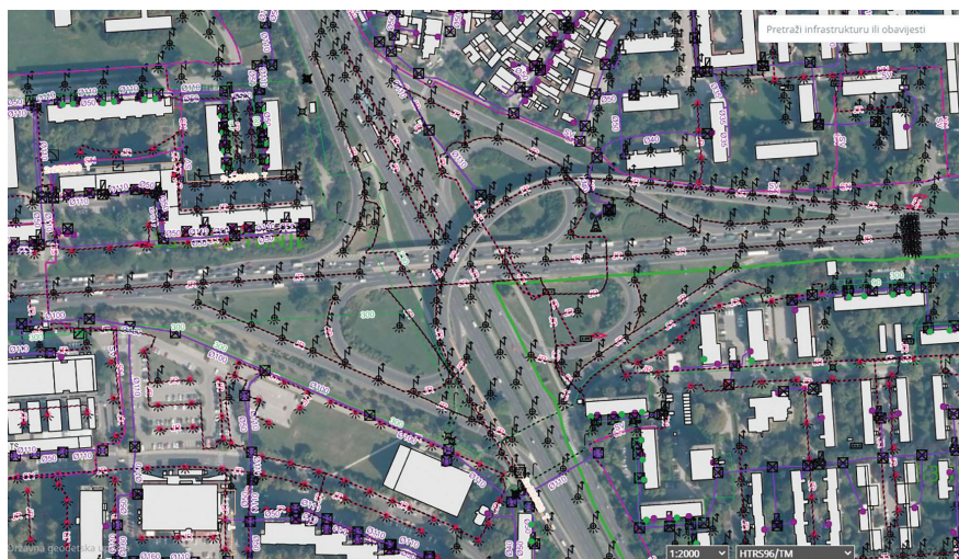
Infrastruktura kod petlje na Aveniji Marina Držića
