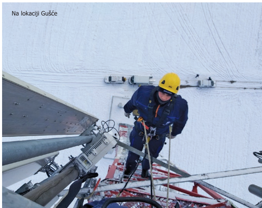
Postavljanje dodatne bazne stanice
